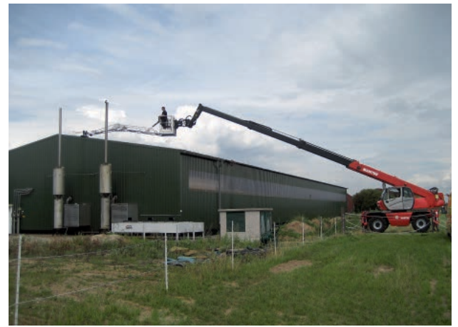
Der Teleskopklader der Firma Solarfresh im Einsatz. Fotos: Solarfresh
